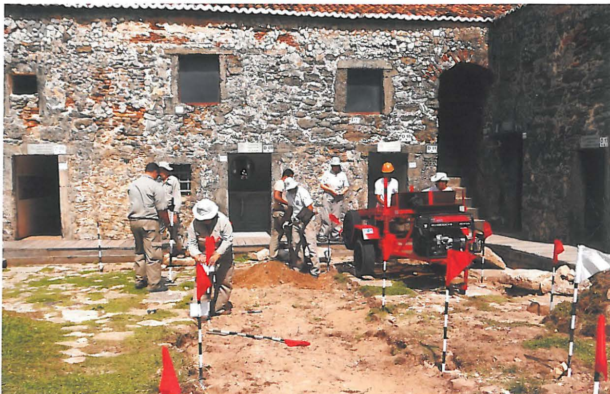
Início das escavações na Praça de Armas.
