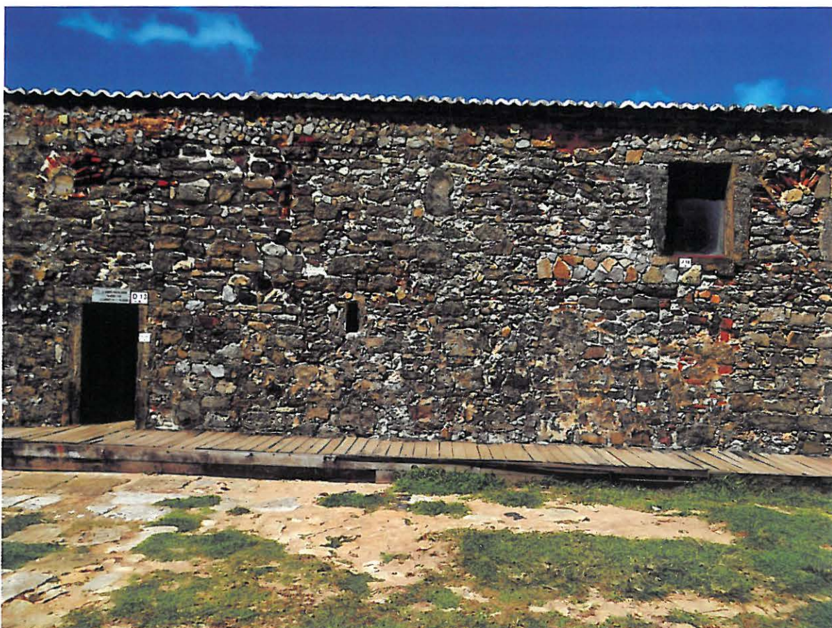
Dependência com seteira de ventilação deve ter sido o primeiro depósito de pólvora, utilizado nos primeiros 20 anos de ocupação do Forte.
